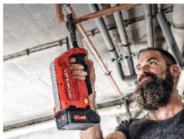
Тwin Turbo при обжиме фитингов на внутренних трубопроводах
