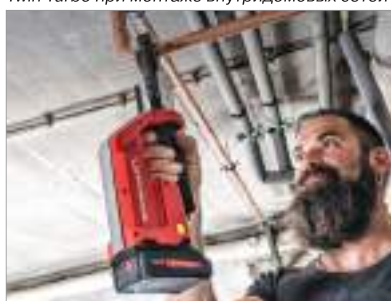
Twin Turbo при монтаже внутридомовых сетей
