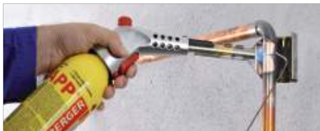
Пайка твёрдым припоем при монтаже системы газоснабжения
