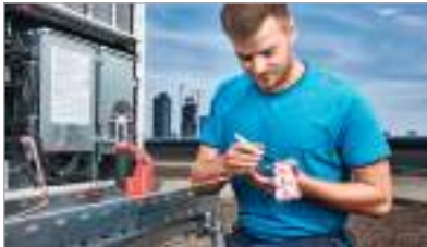
7. Сделайте на трубе отметку, используя калибр для измерения глубины, и полностью введите трубу в фитинг
