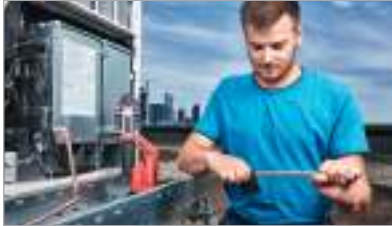
7. Сделайте на трубе отметку, используя калибр для измерения глубины, и полностью введите трубу в фитинг
