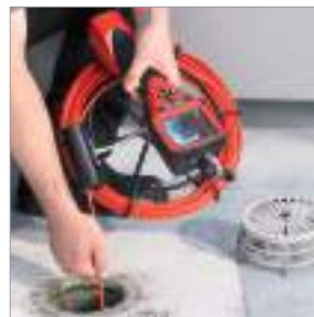
Телеинспекция ливневых труб
